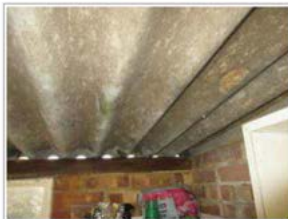
Flaking asbestos
